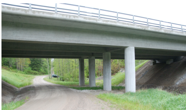
Figur 36. Exempel på en faunapassad vägbro. Källa: Trafikverket 2012.
