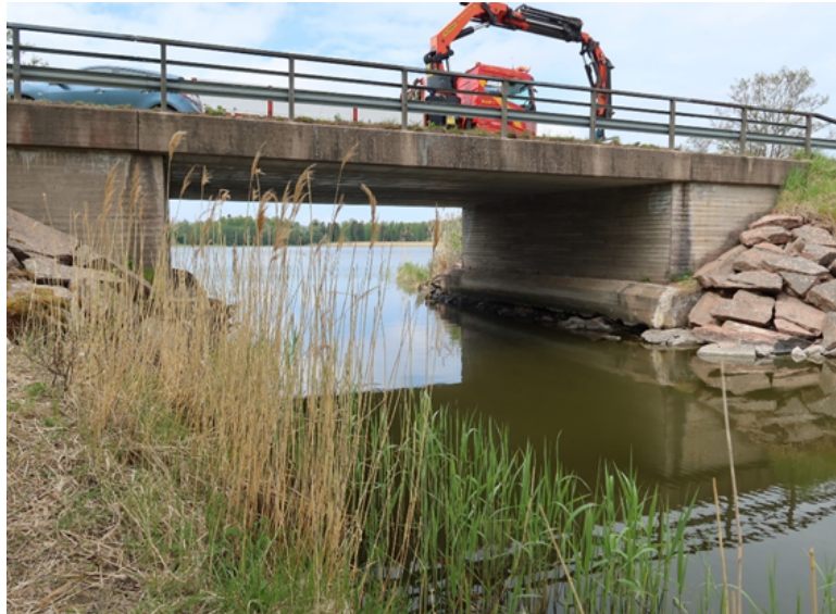
Figur 8. Bro 36 vid Kaldersfjärden
