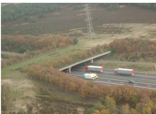
Figur 35. Exempel på en ekodukt där djuren passerar över vägbanan. Källa: Trafikverket, 2012.
