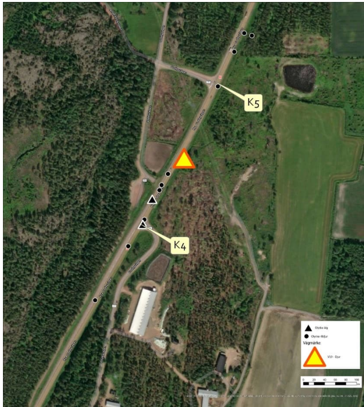
Figur 26. Viltolycksdrabbad vägsträcka på Nya Godbyvägen landsväg 2. Anslutningar av Godbyvägen K4 vid Ingbybacken och Andersbölevägen K5. Älgvarningsskylt norr om de två älgolyckorna.
