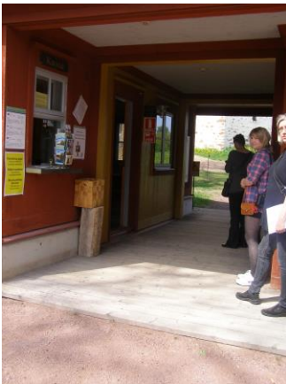
Träkanterna vid passagen genom porthuset bör avfasas med hjälp av träramp i båda ändar.
