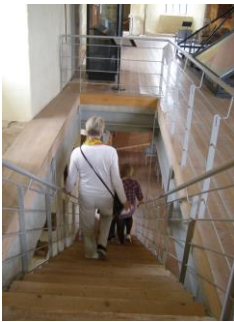
Trappa inne i norra längan kan kompletteras med trapplift alternativt att plattformshiss placeras på annan plats i byggnaden.
