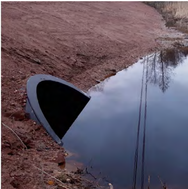
Bilden visar en vägtrumma, som ligger bra och inte hindrar fisk att passera. Trumman leder till Grundfjärden i Herrö, Lemland.
