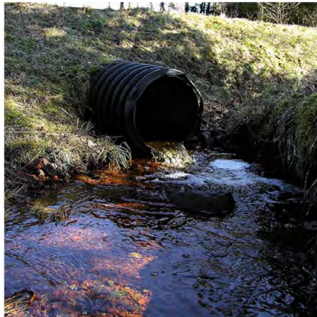
Bilden visar en felplacerad vägtrumma. Fallet nedanom trumman skapar ett vandringshinder för fisk. Trumman leder till Grundfjärden i Herrö, Lemland.
