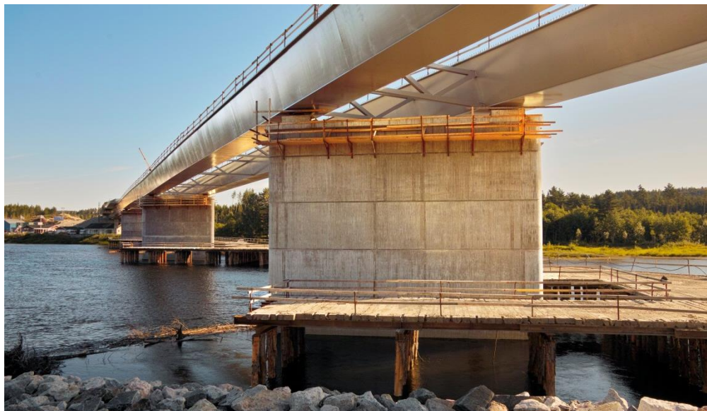
Figur 10. Bro över Ljusnan. Exempel på samverkansbro med dubbla ställådor. Ställådorna är lufttäta och slutna, d.v.s. det görs ingen invändig inspektion. Ställådorna är lanserade. Konstruktion och foto: Ramböll.
