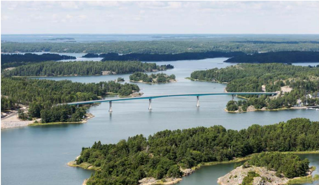
Figur 3. Exempel på samverkansbro med stållåda. Bron är konstruerad av Ramböll. Foto: Ulf B Jonsson.
