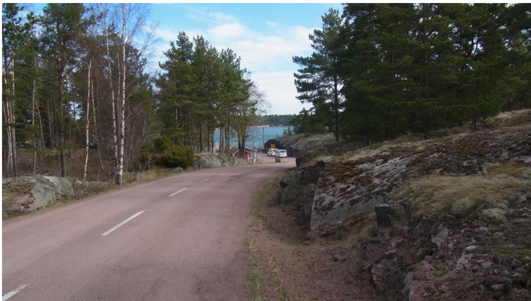
Figur 10. Befintlig väg till linfärjefästet på Finholma. Foto: Vectura.
