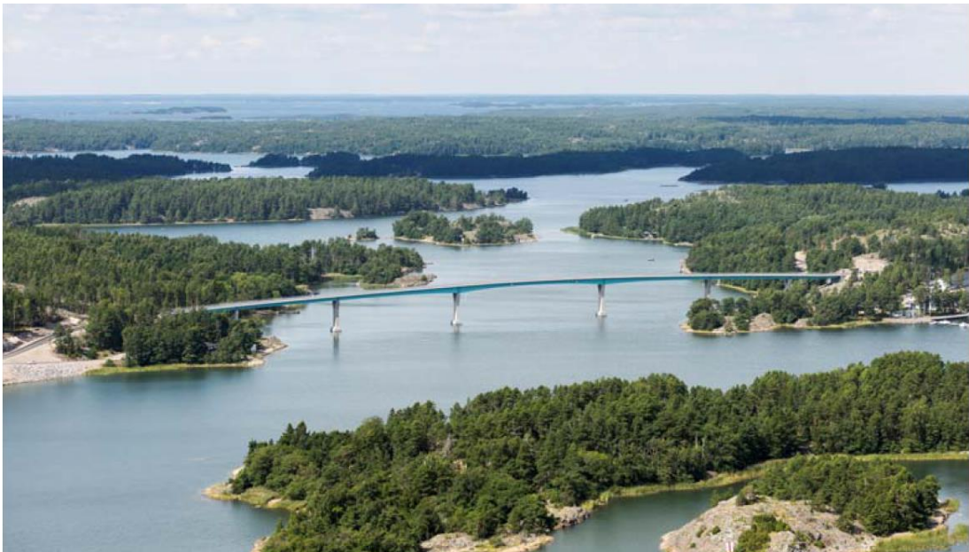
Figur 1. Exempel på samverkansbro med ställåda. Bron är konstruerad av Ramböll. Foto: Ulf B Jonsson.
