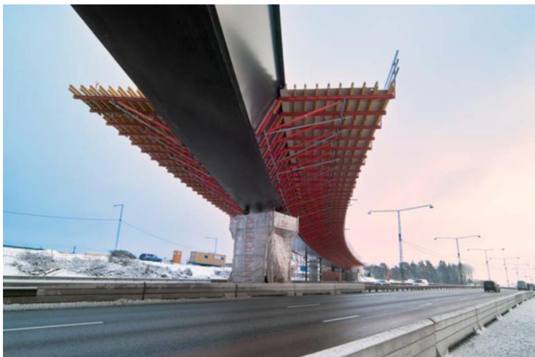
Figur 18. Exempel på form för betongfarbana på en ställåda vid lansering, Bro över E4 i Kista. Konstruktion och foto: Ramböll.
