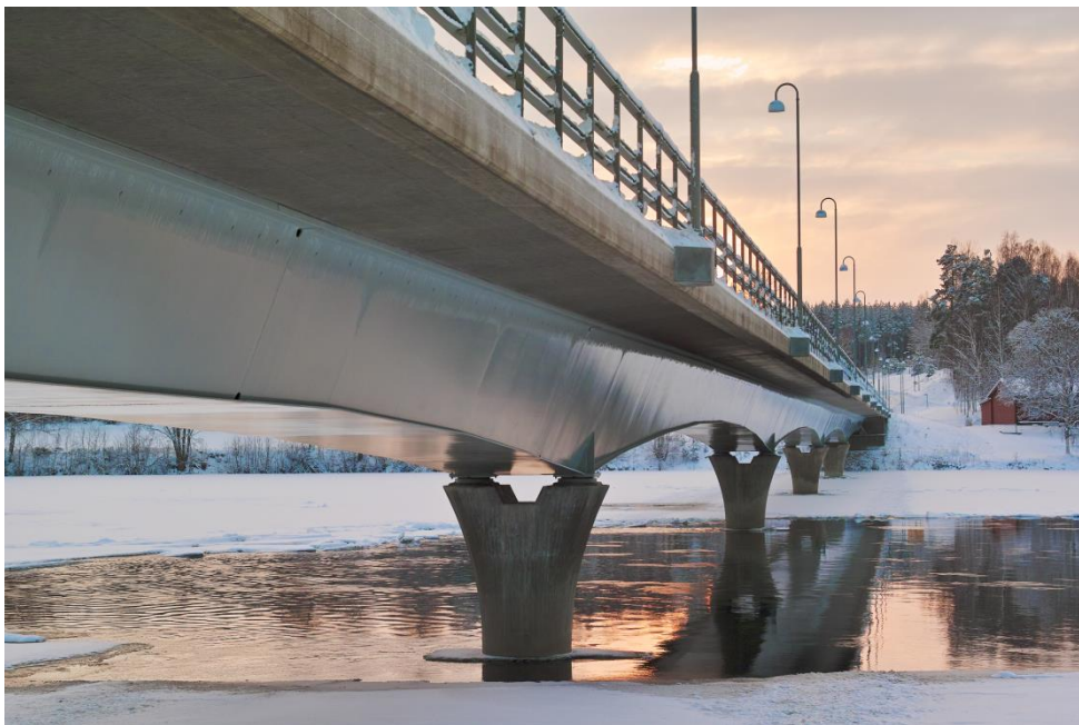
Figur 21. Exempel på samverkansbro med votad stållåda, Bro över Ljusnan vid Segersta. Konstruktion och foto: Ramböll.
