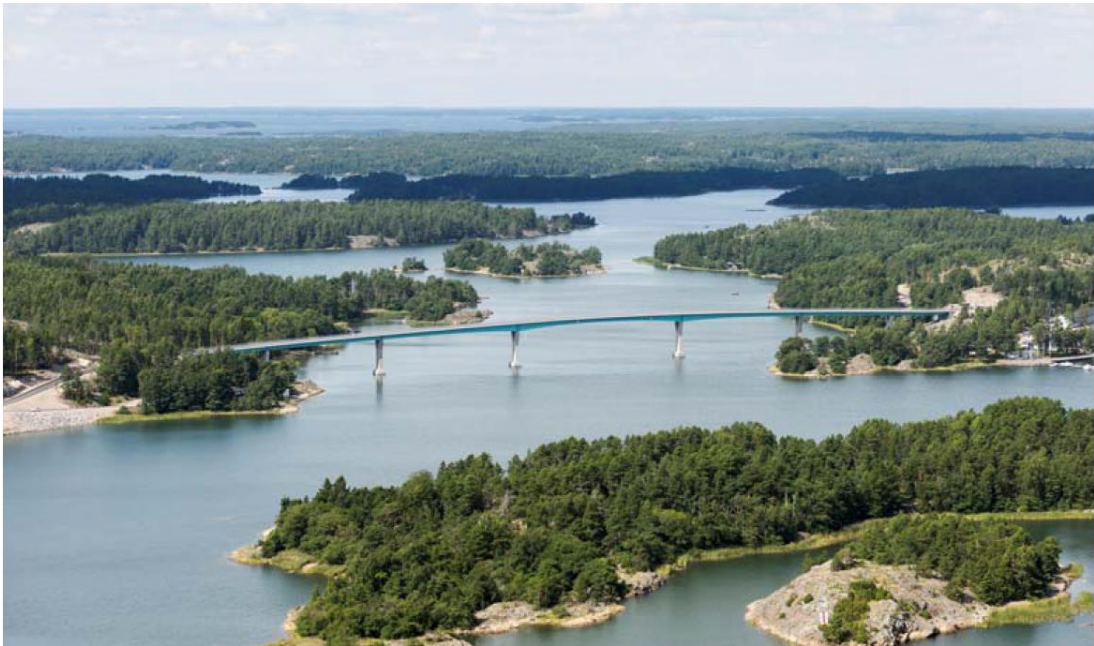
Figur 4. Exempel på samverkansbro med stållåda. Bron är konstruerad av Ramböll. Foto: Ulf B Jonsson.
