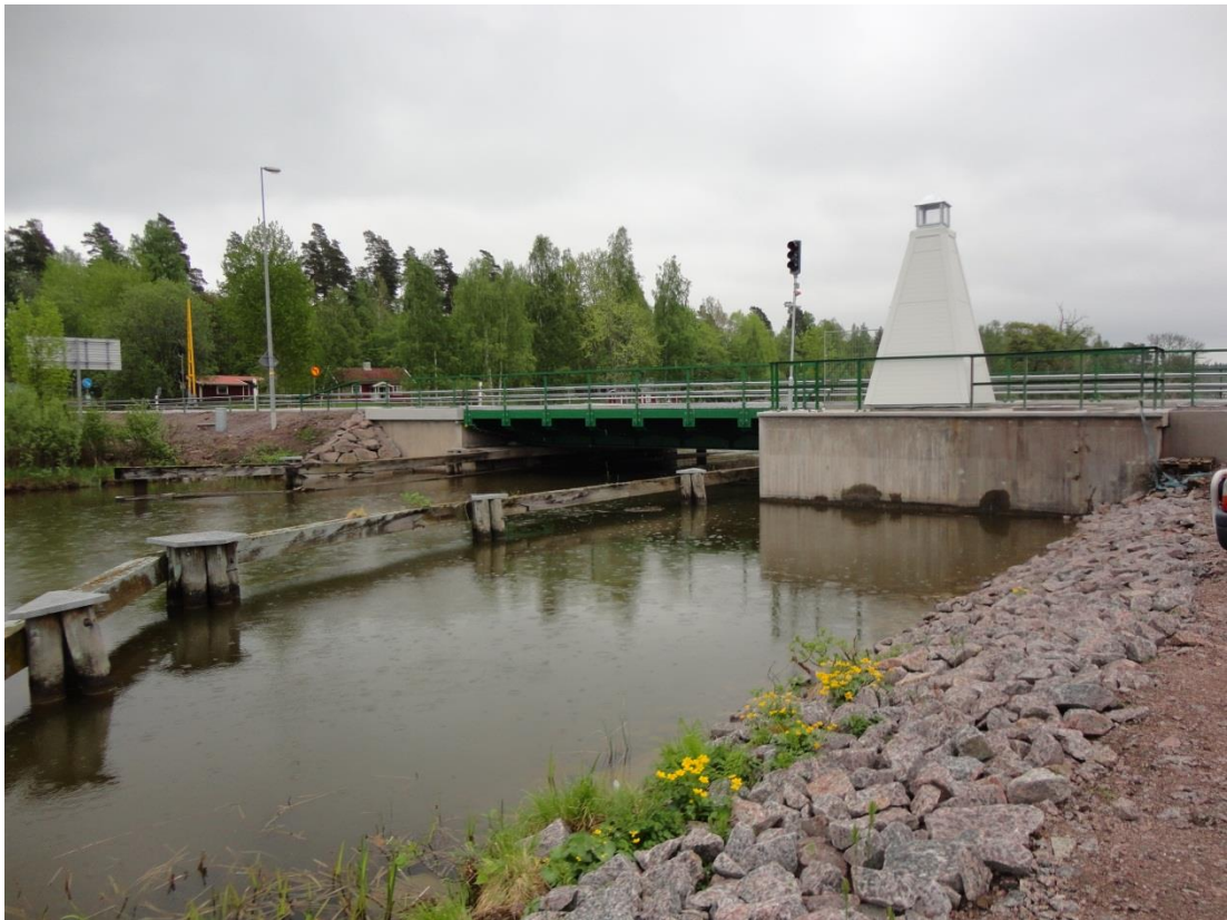
Figur 6. Exempel på klaffbro. Konstruktion och foto: Vectura
