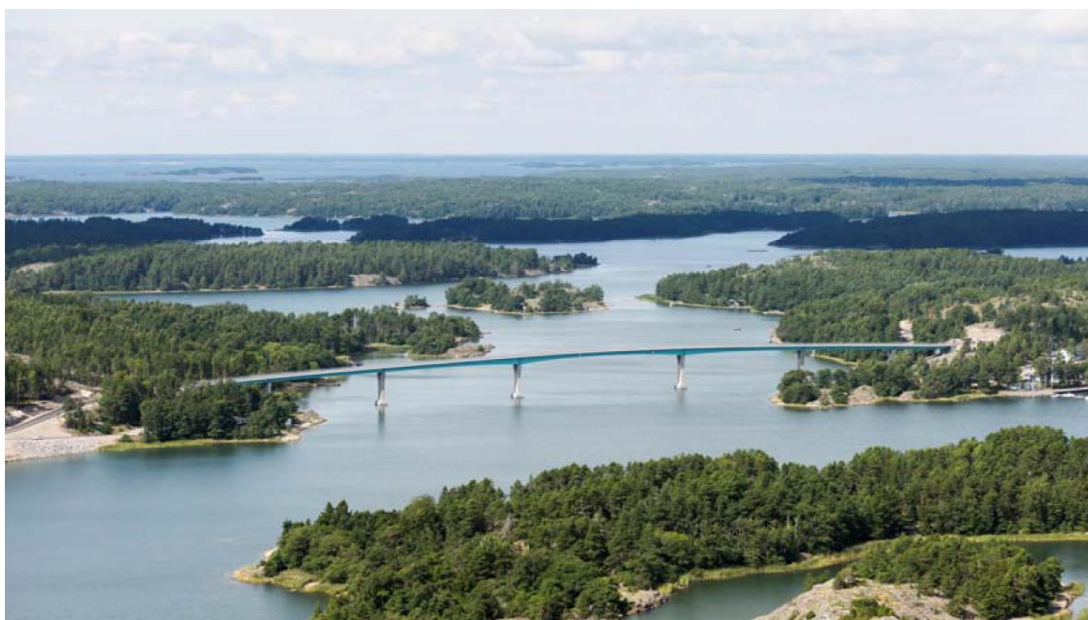
Figur 3. Exempel på samverkansbro med ställåda. Bron är konstruerad av Ramböll. Foto: Ulf B Jonsson.
