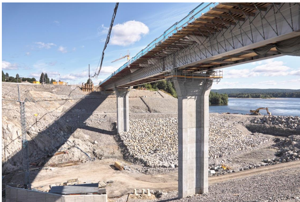
Figur 14 Bro över Bergforsen. Exempel på samverkansbro med stål balkar istället för ställåda. Den här bron har relativt höga pelare så de är kontrollerade för dynamiska effekter av vind. Konstruktion och foto: Ramböll.
