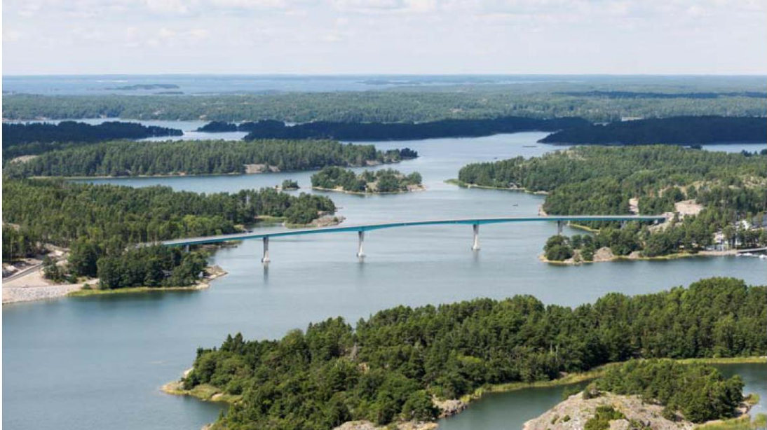
Figur 2. Exempel på samverkansbro med stållåda. Bron är konstruerad av Ramböll. Foto: Ulf B Jonsson.
