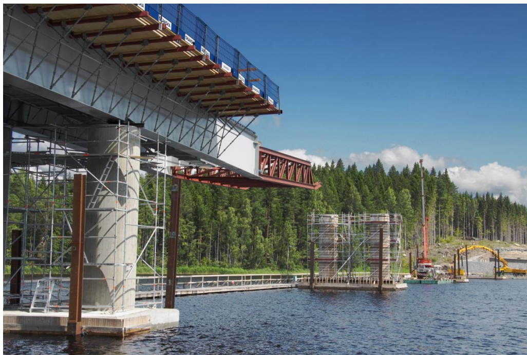
Figur 16. Exempel på samverkansbro med balkar vid lansering, form för betongplatta sitter fast på balkar vid lansering. Konstruktion och foto: Ramböll.
