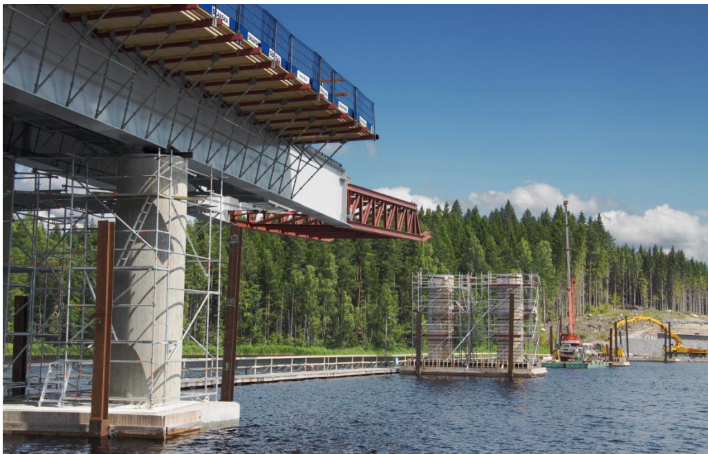
Figur 9. Exempel på samverkansbro med balkar vid lansering, form för betongplatta sitter fast på balkar vid lansering. Konstruktion och foto: Ramböll.
