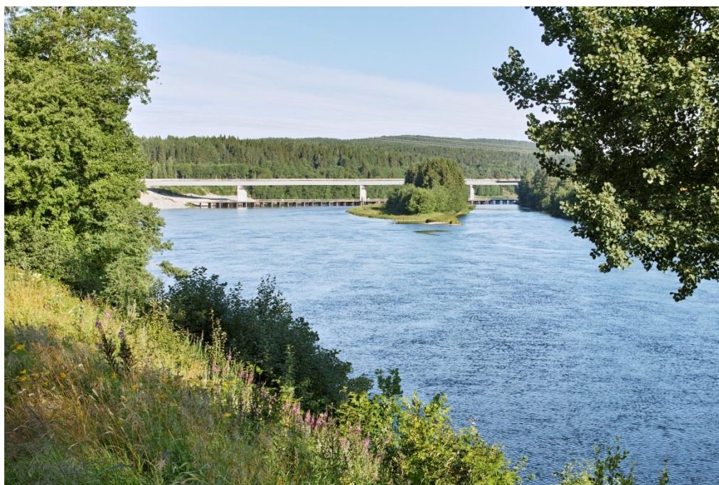
Figur 19. Bro över Ljusnan. Konstruktion och foto: Ramböll.
