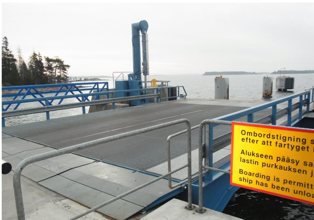
Figur 6. Bild visar samverkande färjefäste på Åland.
