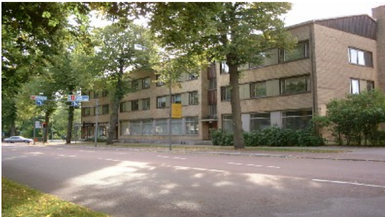
Ålandsvägen 52 i Mariehamn, Mariehamns Telefon Ab Byggt 1969.
