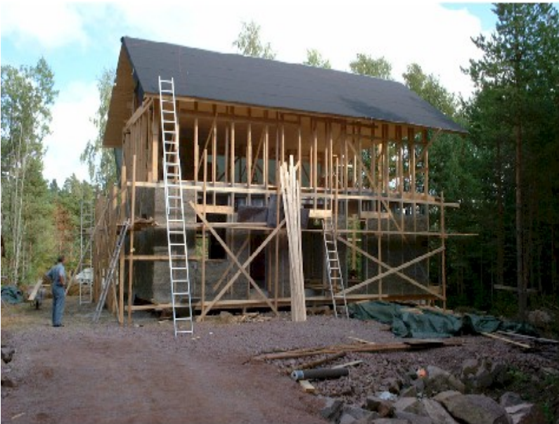
Och så ett hus av annorlunda slag.... Isolering material är lerbunden halm. Isolering materialet är 350 mm på vilket kommer puts på både ytter- och innervägg. 1999.
