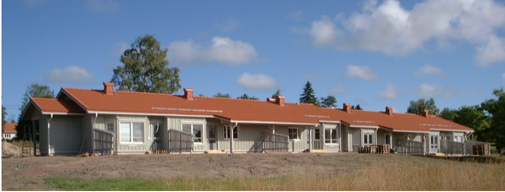
Fastighets Ab Kantorsgården i Kvarnbo, Saltvik. Sex st. nya lägenheter färdigställdes i september 2003
