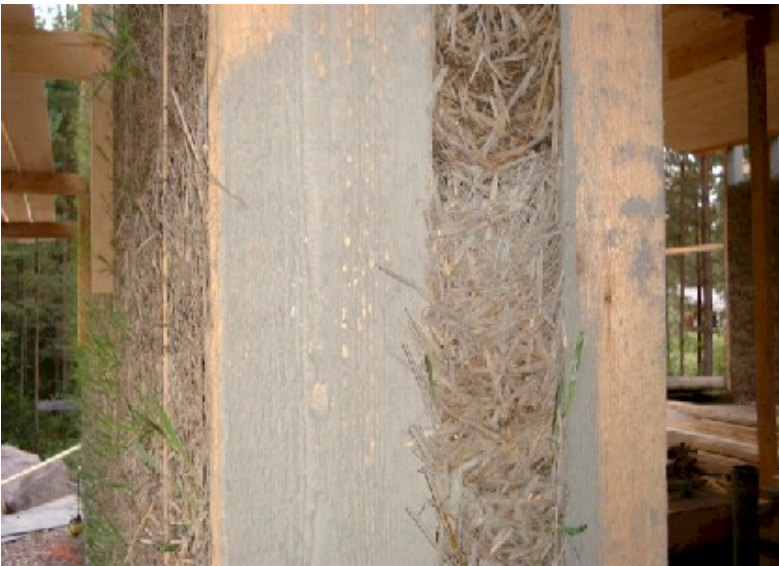
Väggmaterial av lerbunden halm
