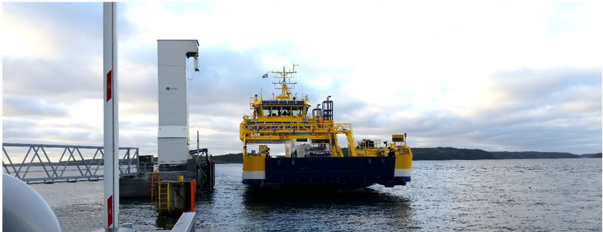
Figur 7 – Finferries laddningsanläggning och elhybridfärjan Elektra.
