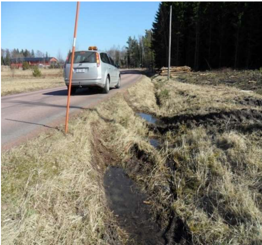
Skador på diken och vägtrummor där den som orsakat skadorna är återställnings-/ersättningskyldig.
