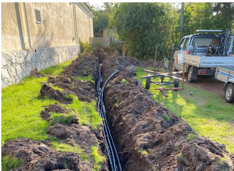
Bild: Rör för den nya bergvärmen vid Eckerö post och tullhus.
