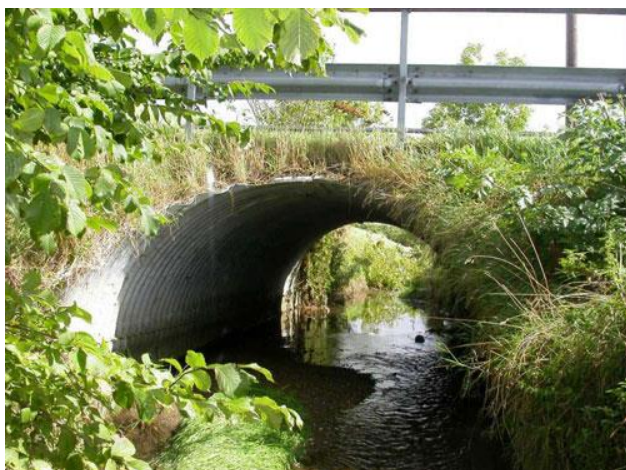
Figur 2.3. Exempel på rörbro.
