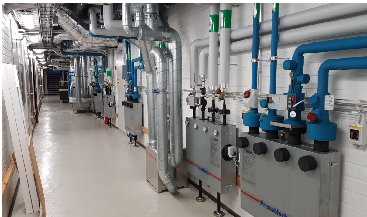
Ny ventilationsanläggning i Ålands museum
