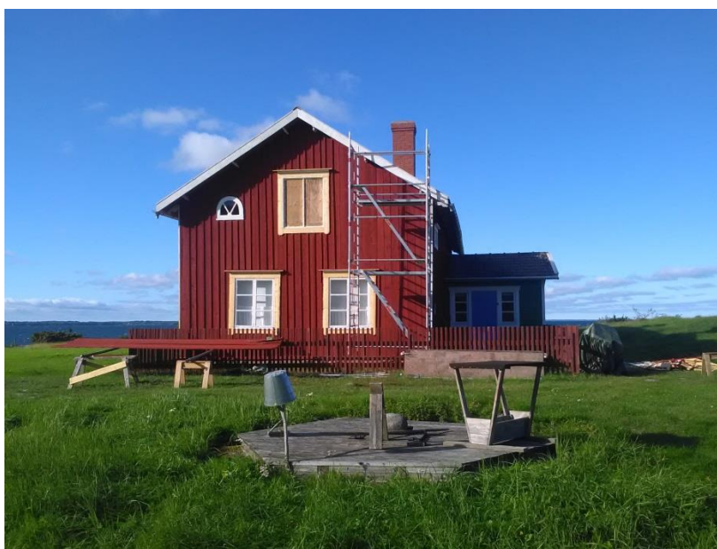
Byte av panel på södra gaveln av mangårdsbyggnaden
