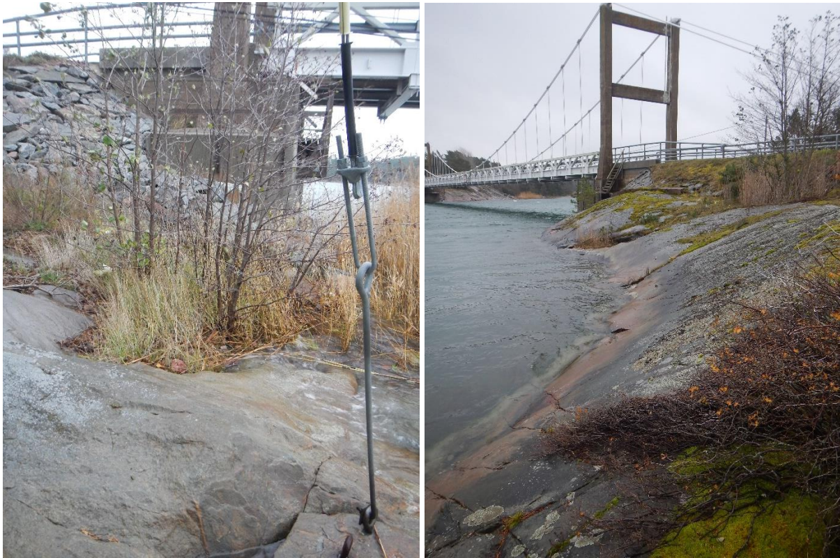
Figur 2, till vänster. Hällmarker västra brofästet, befintlig bro, södra sidan. Figur 3, till höger. På norra sidan är det också hällmarker ned till strandlinjen. De når en höjd av ca 2,5-3 m ca 2,5 m från strandlinjen, hällarna har en förhållandevis brant stupning ut mot vattnet, ca 24°, vy 116°.
