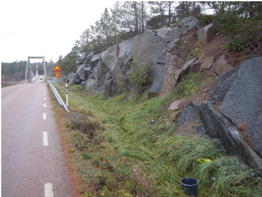
Figur 8. På norra sidan om vägen i nära anslutning till östra brofästet för befintlig bro finns en bergskärning.
