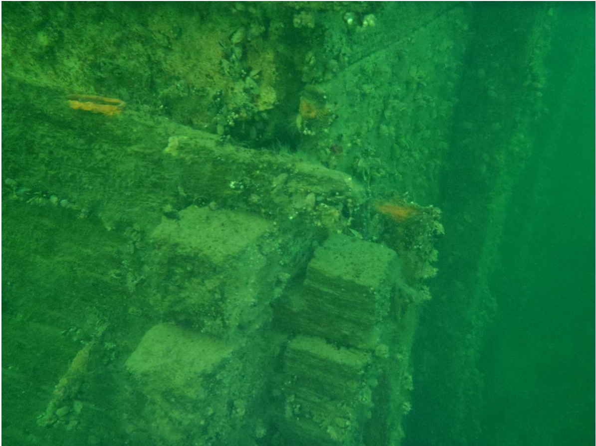
Bild 23: Kvarsittande form på stöd 5.
