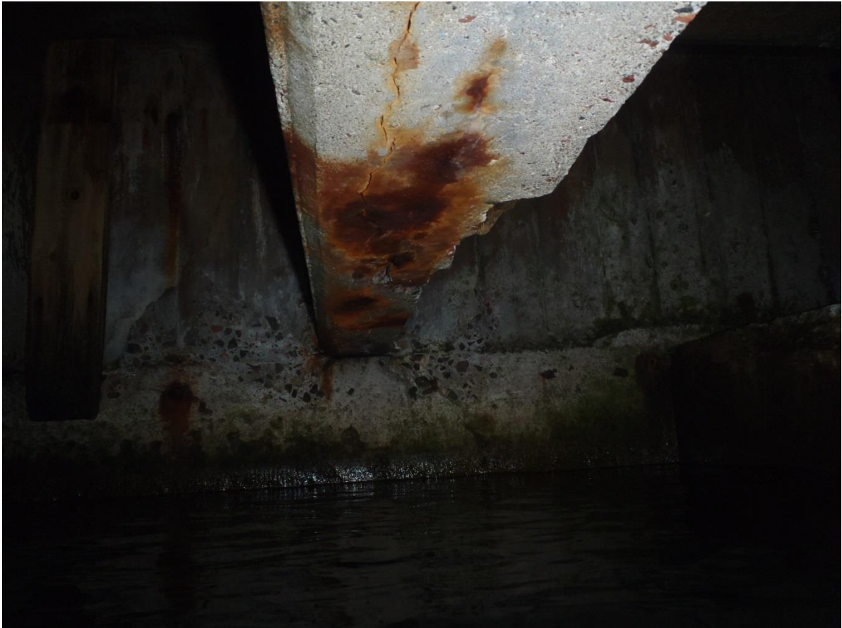
Bild 19: Armeringskorrosion och spjälkningar i pirdäckets huvud- och tvärbalkar.
