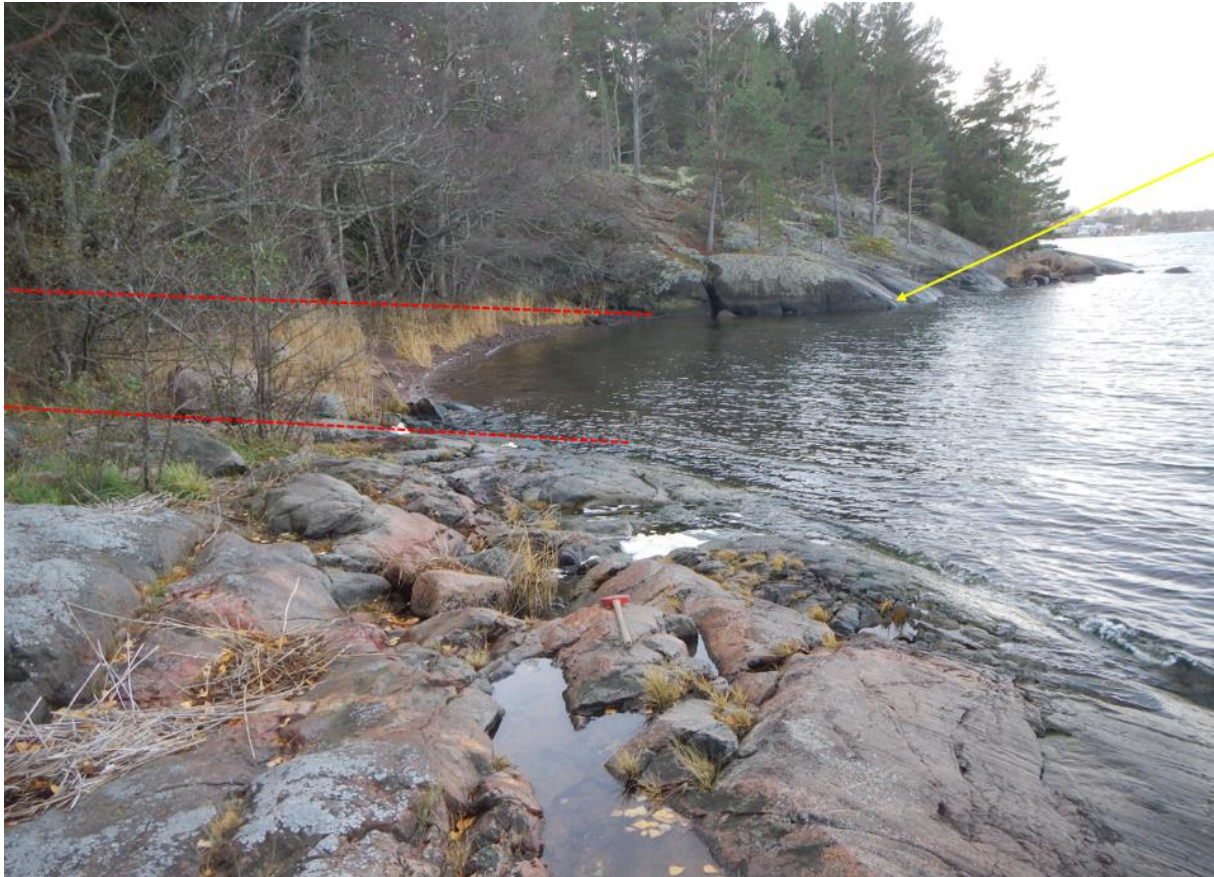
Figur 4. Platsen för brofäste Degerö. Vy 168°, alltså mot sydsydost och planerat brostöd 2, som är placerat i anslutning till vattenlinjen (gula pilen). Brostödet ligger i kanten mot en jordtäckt sprickzon, vars södra gräns (bortre punktsträckade röda linjen i bild), utgörs av ett morfologiskt lineament i form av en brant bergslänt. Den norra gränsen (punktsträckade röda linjen närmast i bild), är morfologiskt mer diffus.
