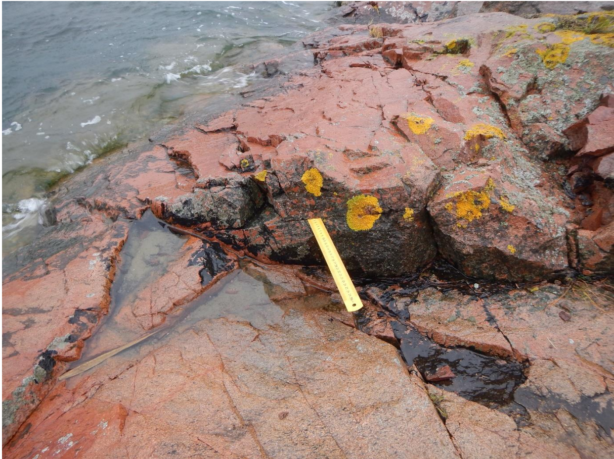
Figur 7. Låga hållar strax norr om brosträckningen. Sprickzon 163/75, 6 m bred och med en spårlängd på 15 m. Zonen innehåller okulärt ca 50 sprickor, men sannolikt rör det sig om minst 100-150 st (gula linjalens långsida parallell med zonens strykning. Här syns också en flack sprickgrupp, 018/30, som stupar ut i sundet (gula linjalen instucken längs en sådan flack spricka.
