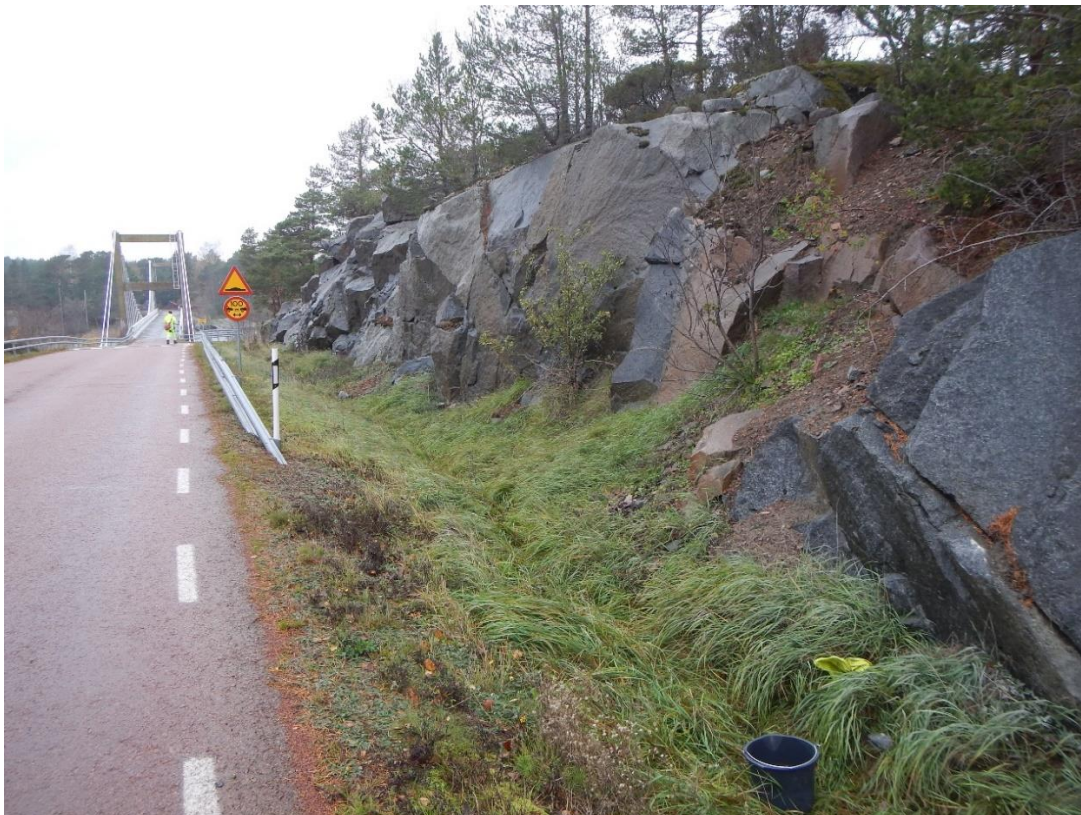
Figur 8. På norra sidan om vägen i nära anslutning till östra brofästet för befintlig bro finns en bergskärning.
