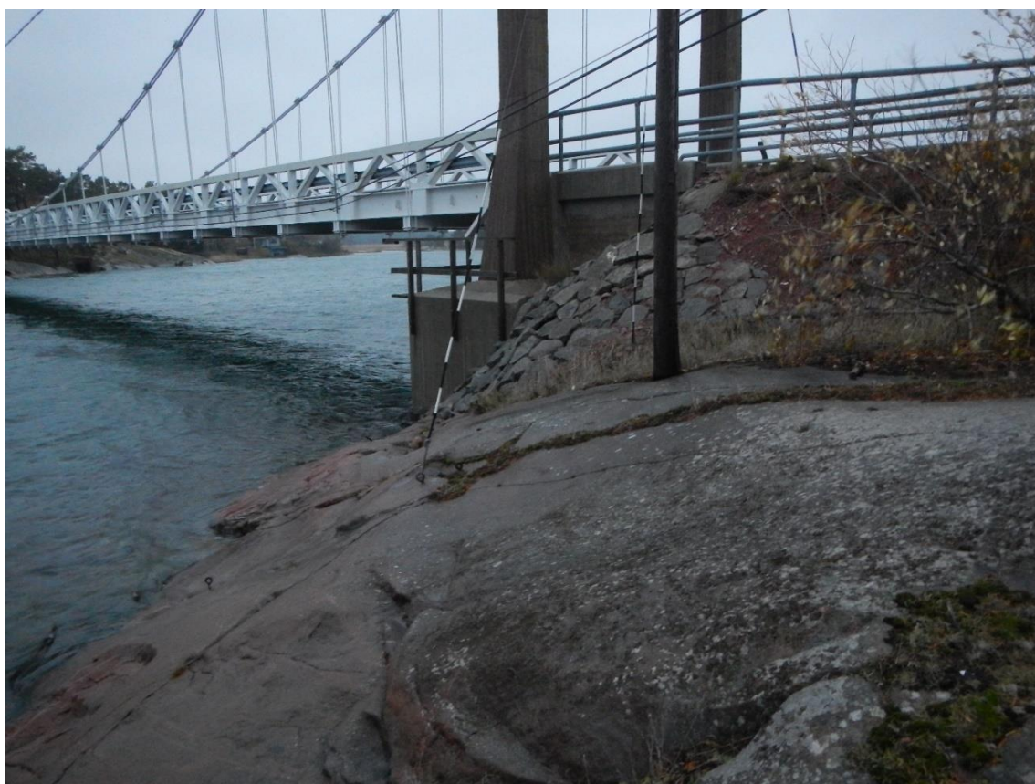
Figur 5. Hällmarker östra brofästet, befintlig bro, södra sidan, vy 305°.
