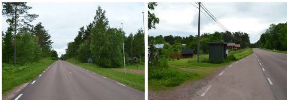
Figur 5.22 Dagens väg genom Prästö. Vägren saknas. Fotot till vänster är taget vid campingen, det högra är taget vid busshållplatsen på mitten av Prästö.
