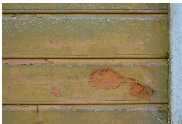
T.v. ytterdörren med de tvådelade inre dörrbladen från öster. T.h. detalj av fasadpanelen, där äldre ytbehandling skymtar fram under den nuvarande i samma kulör.
