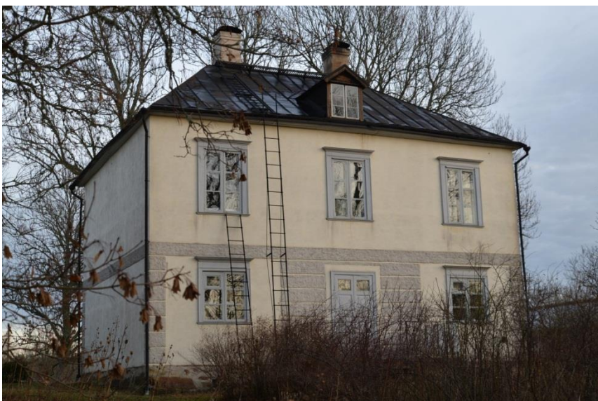
Figur 5. Fasad mot väster. Foto: C Andreasson
