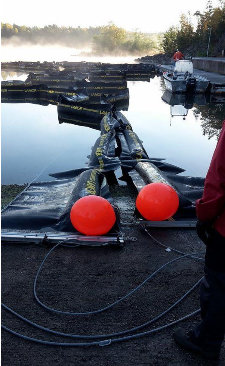
Bild 1. 2 x 200 meter havslänsor sammankopplade med vajer
